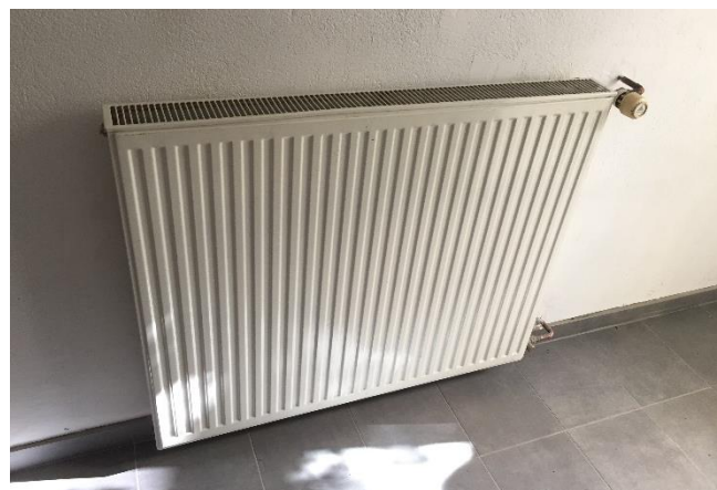
Slika 6.9: Posnetek ploščatega panelnega radiatorja Vir: lastni vir.
