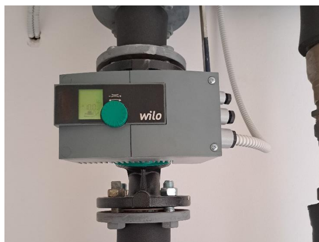
Slika 6.7: Posnetek frekvenčno vodene obtočne črpalke WILO, tip Stratos 40/1-10 Vir: lastni vir.
