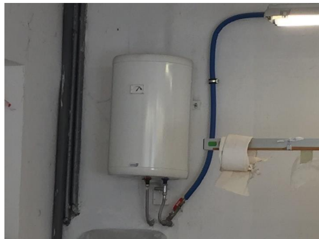
Slika 6.14: Električni bojler v restavratorski delavnici Vir: lastni vir.
