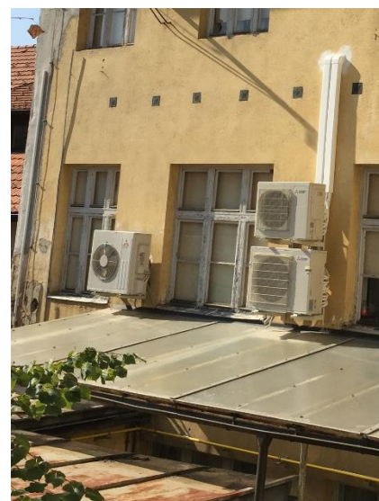
Slika 6.30: Posnetek notranje in zunanjih (split) klimatskih naprav Vir: lastni vir.
