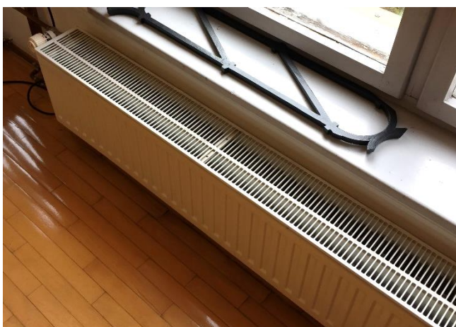
Slika 6.10: Posnetek ploščatega panelnega radiatorja Vir: lastni vir.
