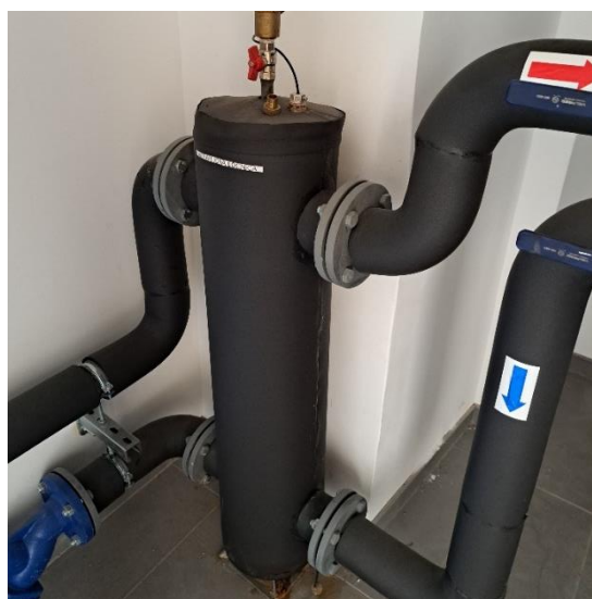
Slika 6.5: Posnetek hidravlične ločnice Vir: lastni vir.
