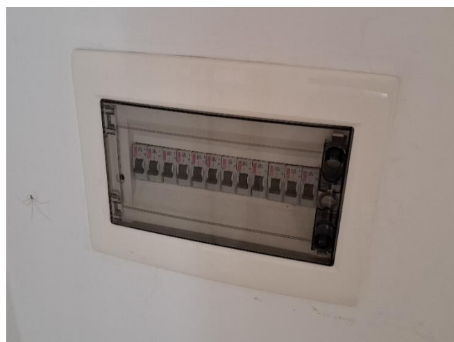
Slika 6.22: Posnetek etažnega podrazdelilca Vir: lastni vir.
