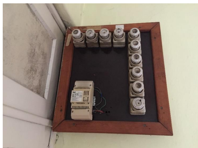
Slika 6.24: Posnetek starega etažnega razdelilca Vir: lastni vir.
