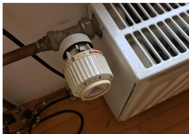
Slika 6.11: Posnetek termostatske glave Vir: lastni vir.
