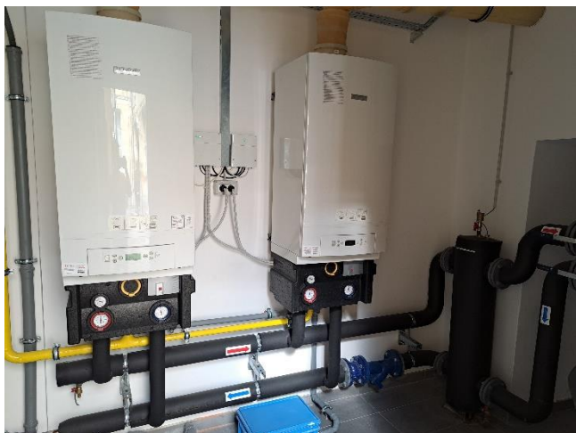
Slika 6.2: Posnetek plinskih kondenzacijskih kotlov, Bosch Condens 5000 W Vir: lastni vir.
