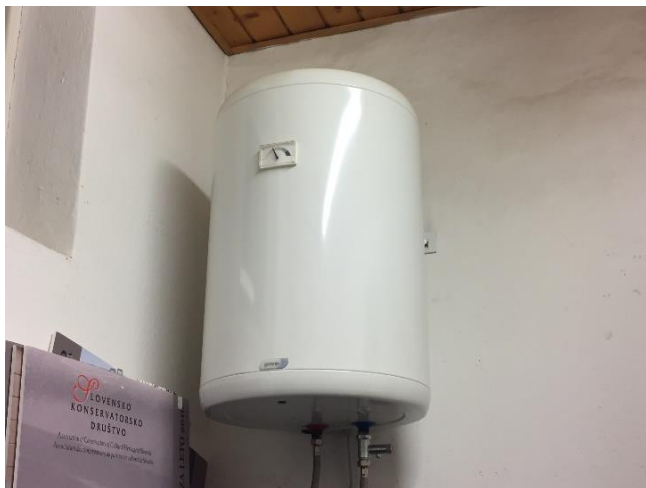
Slika 6.13: Električni bojler v predprostoru kuhinje Vir: lastni vir.
