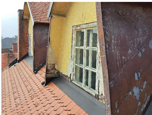
Slika 7.9: Posnetek dotrajanega lesenega okna v mansardi Vir: lastni vir.
