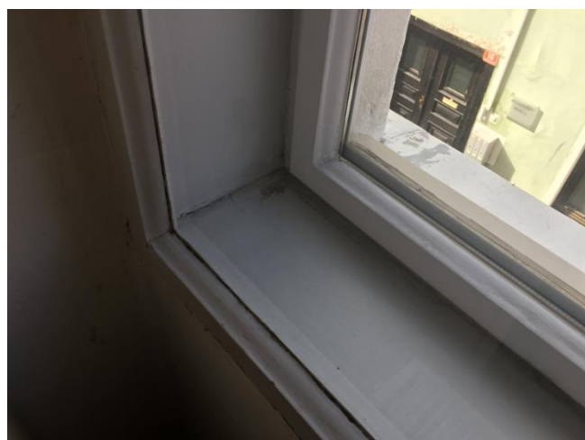
Slika 7.12: Posnetek obnovljenega škatlastega okna Vir: lastni vir.
