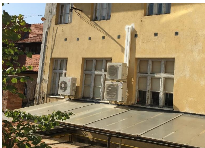
Slika 7.28: Posnetek zunanjih enote klimatske naprave II
