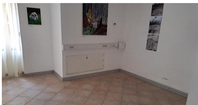
Slika 6.12: Posnetek razdelilne omarice talnega ogrevanja v razstavnem prostoru Vir: lastni vir.
