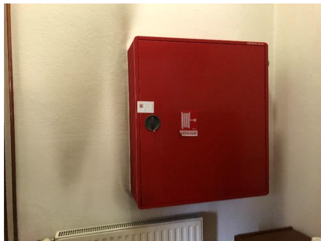
Slika 6.18: Posnetek hidrantne omarice za potrebe požarne varnosti
