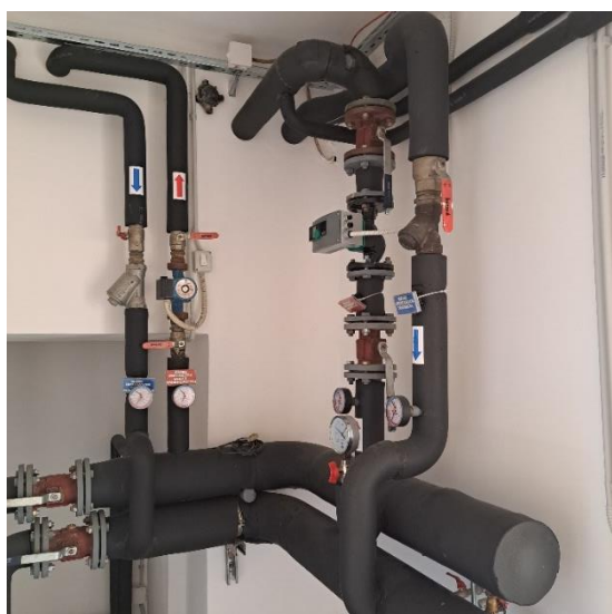
Slika 6.4: Posnetek dveh ogrevalnih vej radiatorskega ogrevanja Vir: lastni vir.
