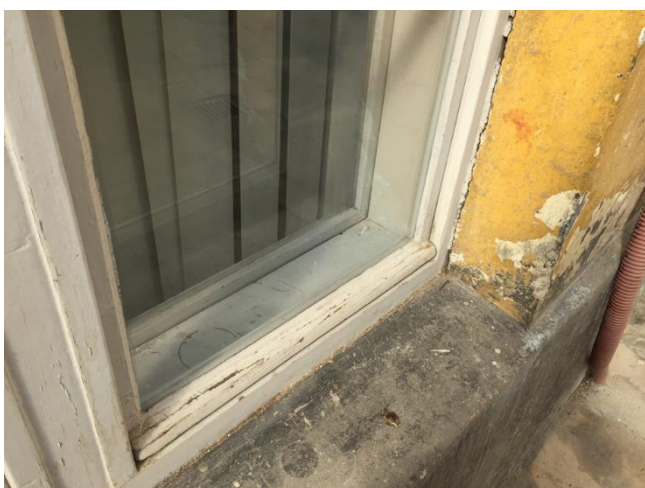
Slika 7.11: Posnetek prvotnega škatlastega okna Vir: lastni vir.
