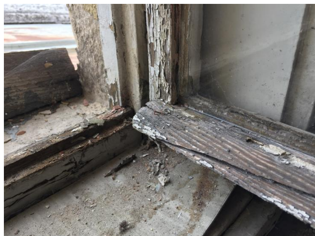
Slika 7.10: Posnetek detajla dotrajanega okna Vir: lastni vir.
