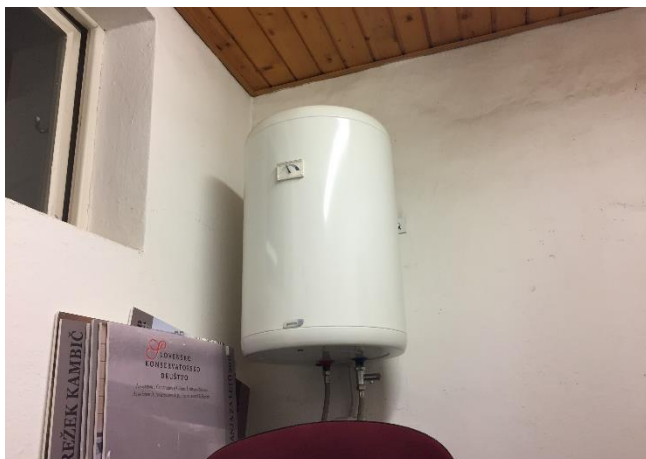
Slika 6.28: Posnetek električnega bojlerja za pripravo TSV Vir: lastni vir.
