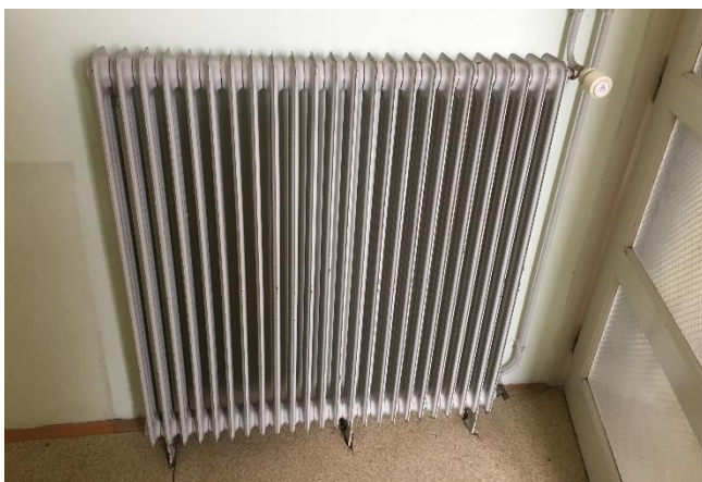
Slika 6.8: Posnetek rebrastega radiatorja Vir: lastni vir.
