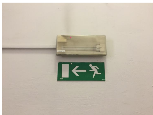
Slika 7.23: Posnetek zasilne (varnostne) razsvetljave z označbo poti umika
