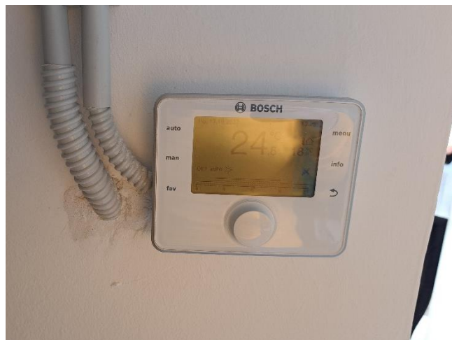
Slika 6.3: Posnetek regulacije ogrevanja Bosch Vir: lastni vir.
